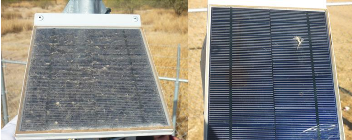
Figura 9. Fotografías que muestran: panel solar con exceso de polvo y panel con fractura y raspones.
